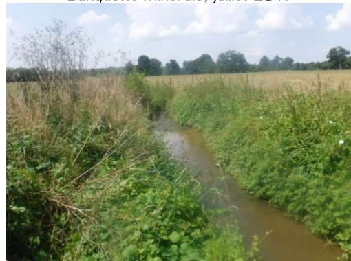
Aval pont, juillet 2018
