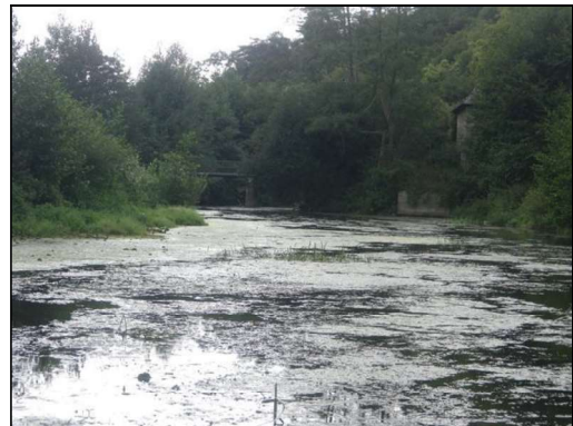
Amont ouvrage en 2012
