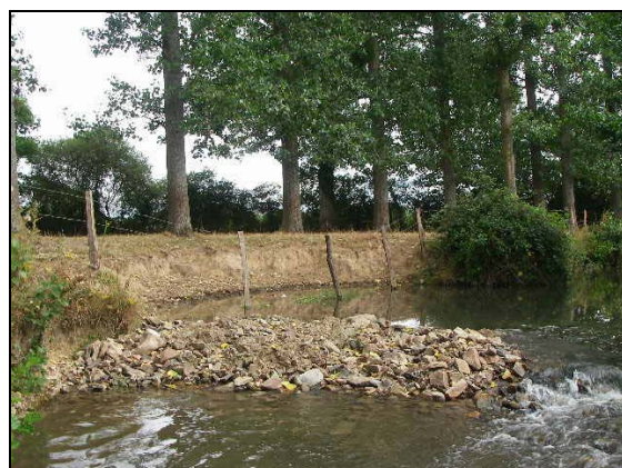
Seuil installé en 2010 par un agriculteur
