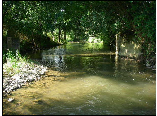
Culées de l'ancien ouvrage, seuil en pierre et abreuvoir en aval en 2009
