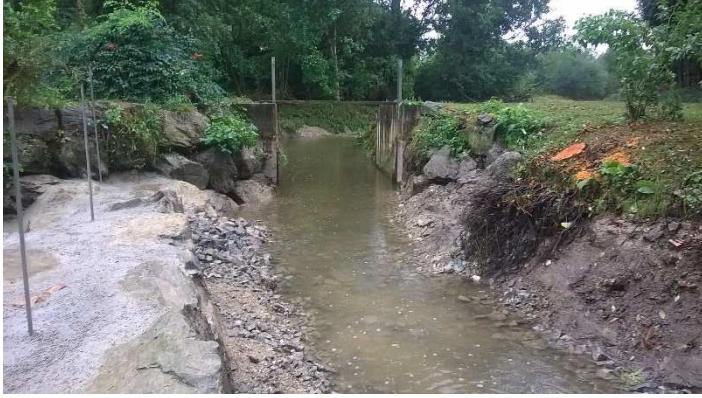
Mini seuil pour maintenir un niveau d'eau sur le radier de l'ancien barrage
