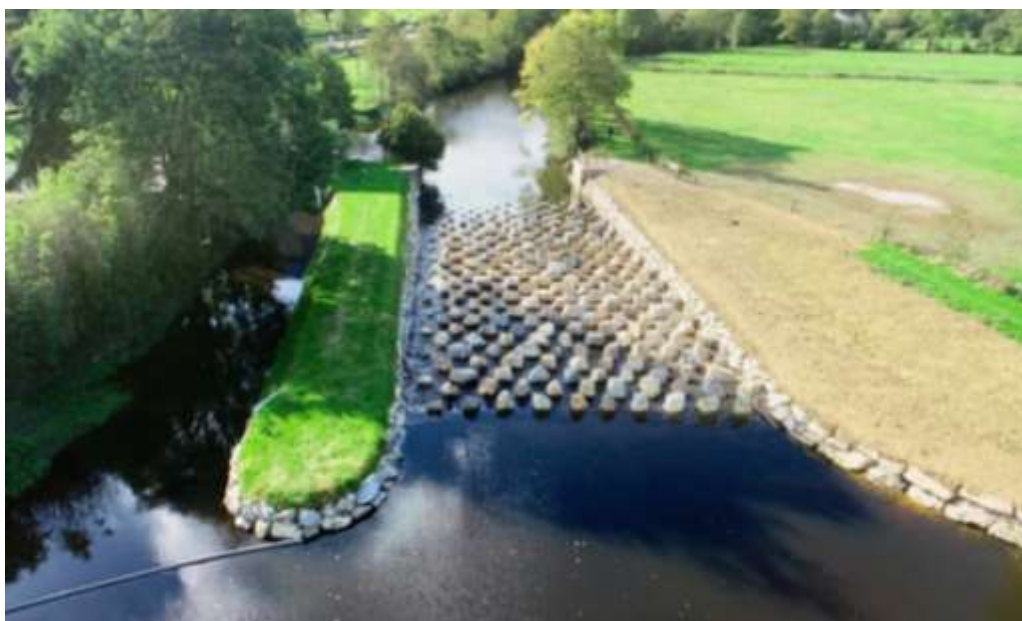
Aménagement du Moulin Neuf à ARGENTRE
